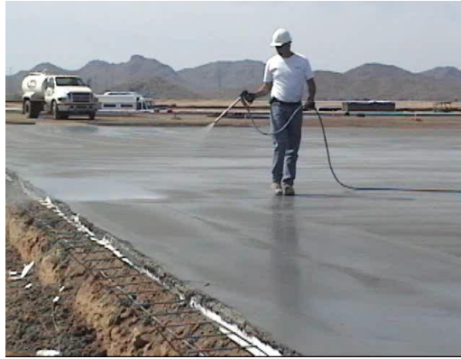
图 5 Pentra Hard 材料自然干燥后即可结束施工，无需清洗
